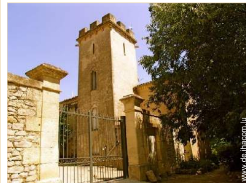
exklusives ehem. Priorat
