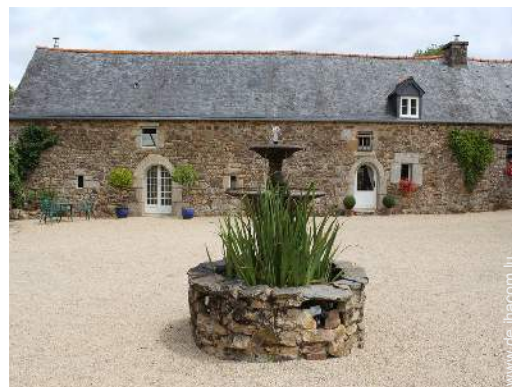
Steingebäude mit Charme
