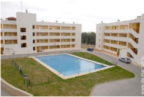
Swimmingpool in Wohnanlage
